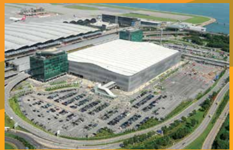
Building Construction 樓宇建築 Hong Kong International Airport SkyPlaza 香港國際機場翔天廊
