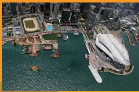
Civil Engineering 土木工程 Central-Wan Chai Bypass at Wai Chai East & HKCEC 中環灣仔繞道灣仔東段及香港會議展覽中心段
